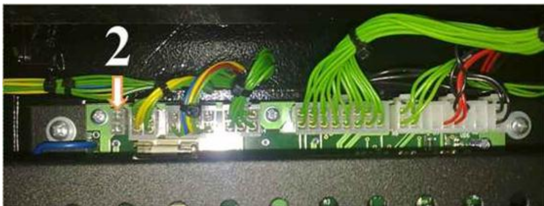
Рисунок 3.3.3 – Подключение кабеля питания (2)
